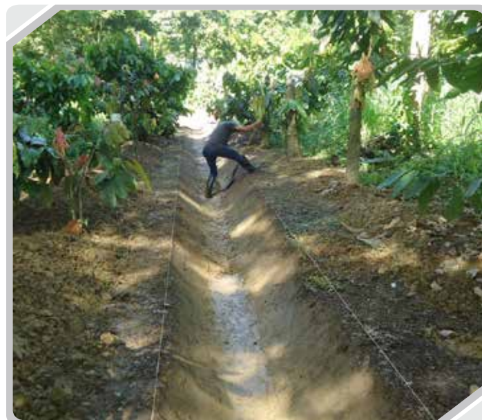
Canal de drenaje adecuado.
