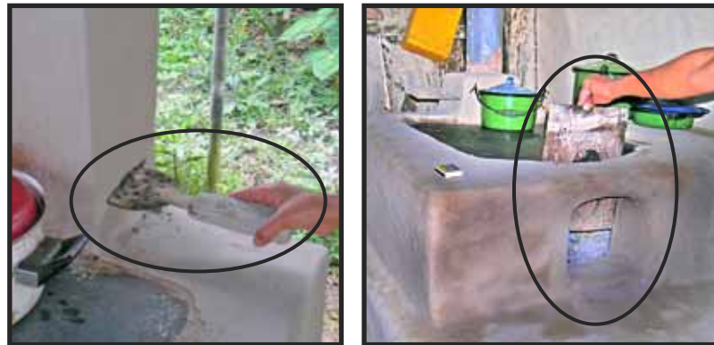
Regulador de la chimenea.
