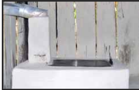
Con 2 ó 3 bases de chimenea y un codo de lámina con salida a la pared. Se recomienda utilizarla en casas con paredes de madera o manaca.
